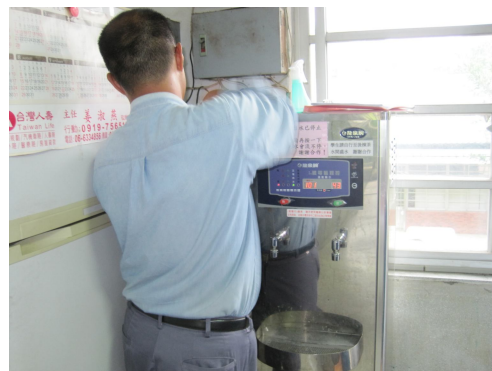
定期更換飲用水相關設備
