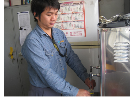
定期更換飲用水相關設備
