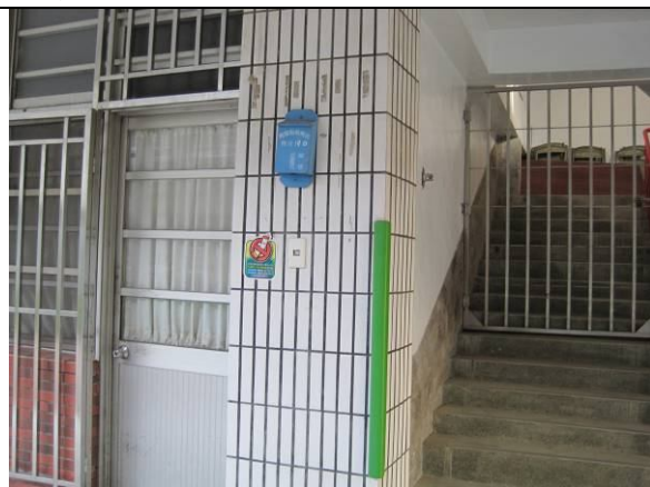
學校安全設施- 裝設後壁警察局巡邏箱
